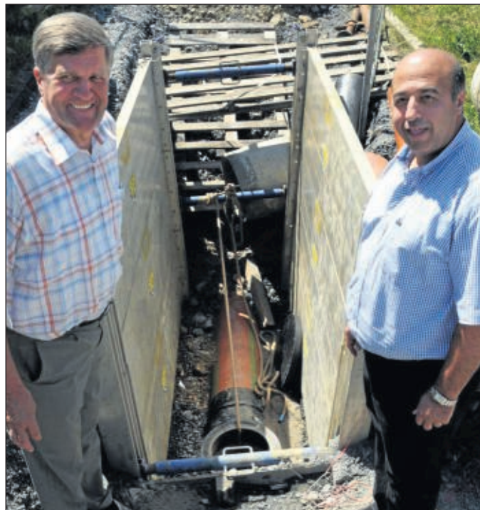
Am Feuerwehrhaus wurde im Beisein von Bürgermeister Gödde und Ingenieur Kayed das Abwasser aus dem Provisorium eingeleitet.
